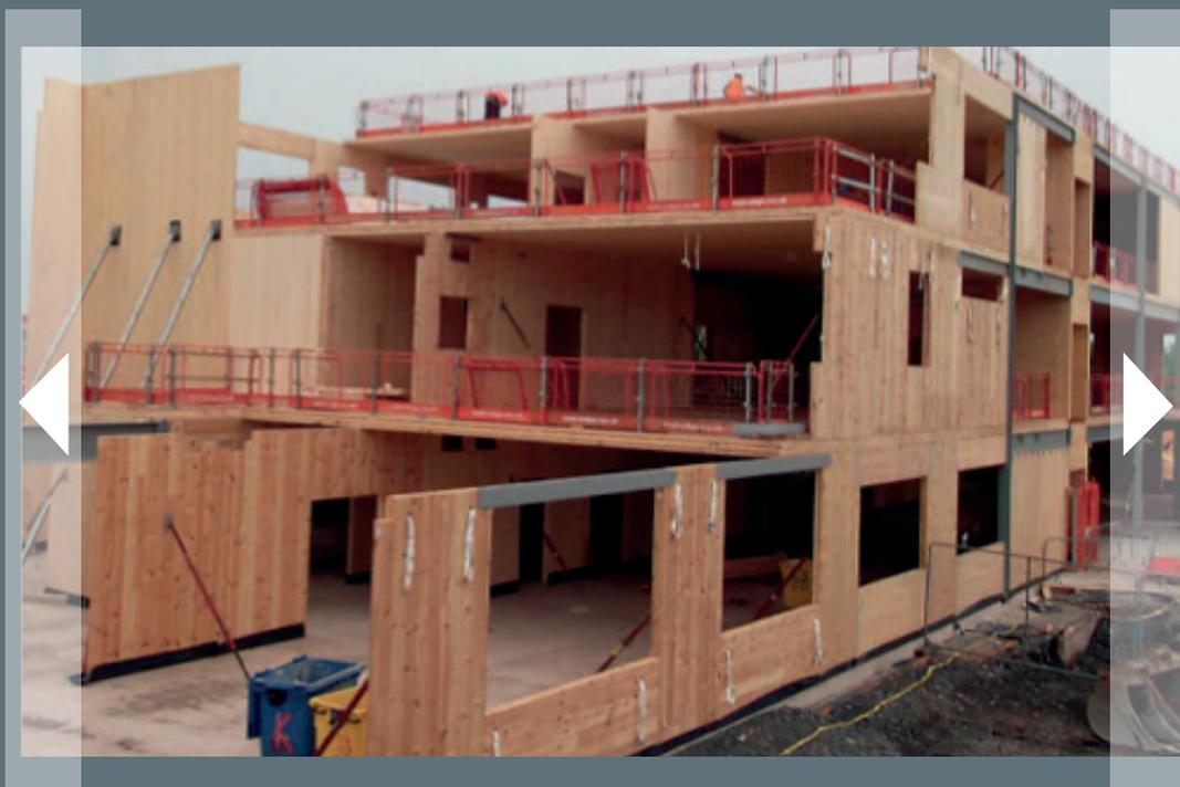
da elementi X-LAM con intelaiatura in legno lamellare poggianti su pilasti in legno composito (parallel strand lumber) con connessioni in acciaio. L'involucro dell'edificio è costituito da pannelli prefabbricati in acciaio con rivestimento in laminato di fibra di legno.
