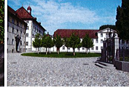
20 Als ersten realisierten Baustein eines Masterplans hat das Büro Vogt Landschaftsarchitekten aus Zürich den Abteigarten des Klosters Einsiedeln im Kanton Schwyz neu gestaltet.
