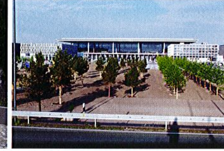
30 Am 3. Juni hätten die ersten Flugzeuge vom neuen Berliner Flughafen starten sollen. Daraus wurde nichts. Wir haben uns die Außenanlagen angesehen.
